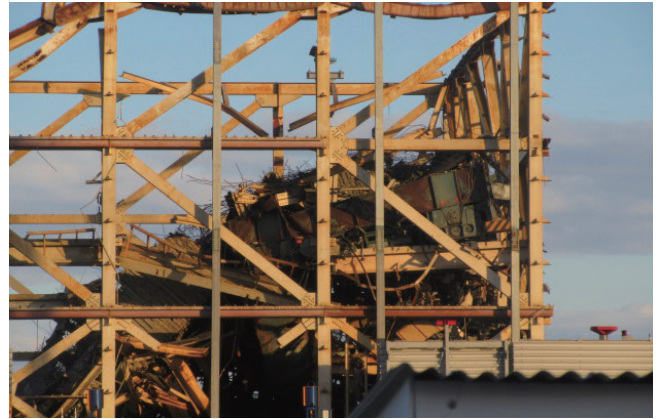
今なお解決していない福島第一原子力発電所事故の様子
