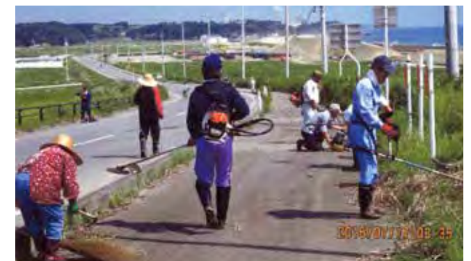
地元住民による道路の草刈り作業
