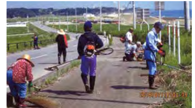
地元住民による道路の草刈り作業
